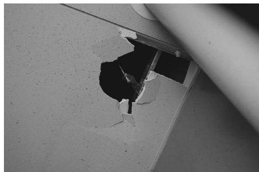
写真 3 破損したベランダの天井
