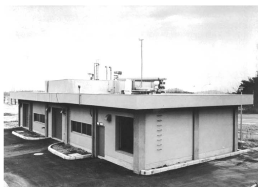
竣工時の無機廃液処理施設（1976 年）
