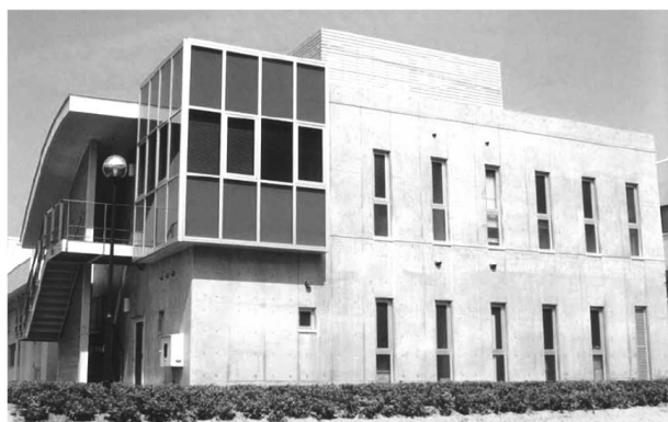
更新時の無機廃液処理施設（2007 年）
