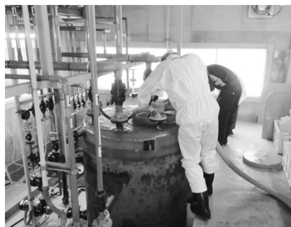
処理槽内の洗浄
